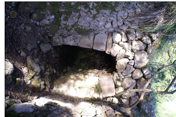
164-1: Detalle de la boca de la Font de Mina.
