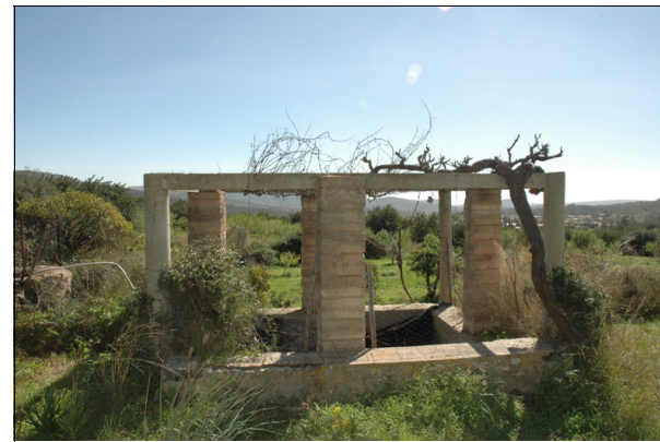
Descripción: Alberca junto a la sinia con mota, columnas y entramado de vigas.
