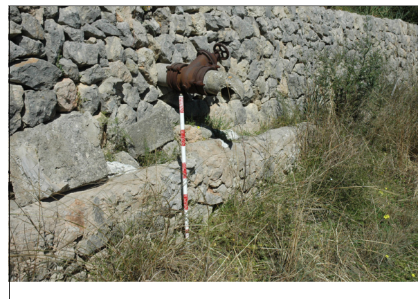
Descripción: Desagüe del safareig inserto en el marge que desemboca en una acequia.
