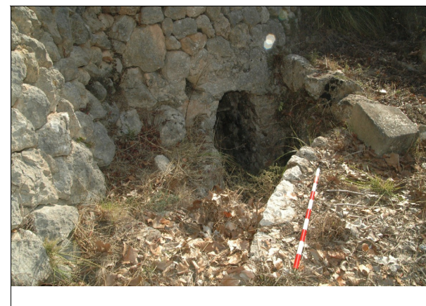
Descripción: Acceso a la font de mina.
