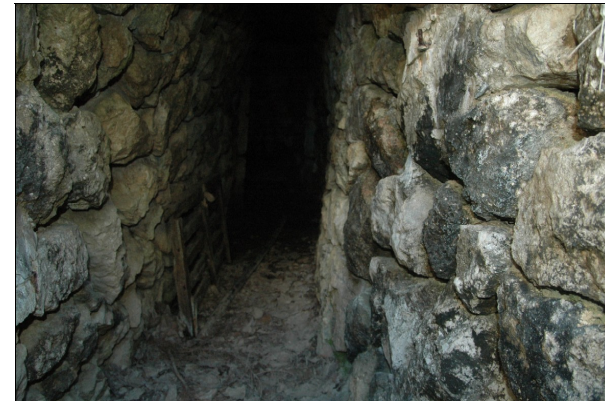
Descripción: Galería de la font de mina, al fondo pozo de aireación.
