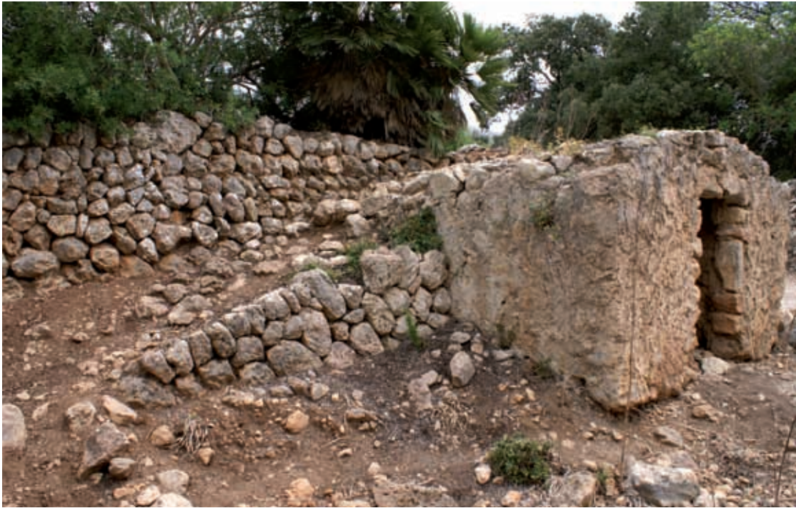
Figura 200. Granero del diezmo de Galatzó. Rampa de acceso a la cubierta.
