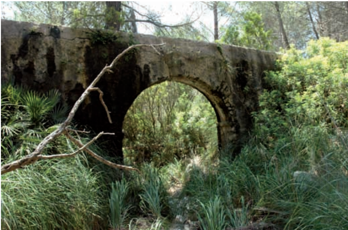
Figura 187. Viaducto del sistema hidráulico de Galatzó.
