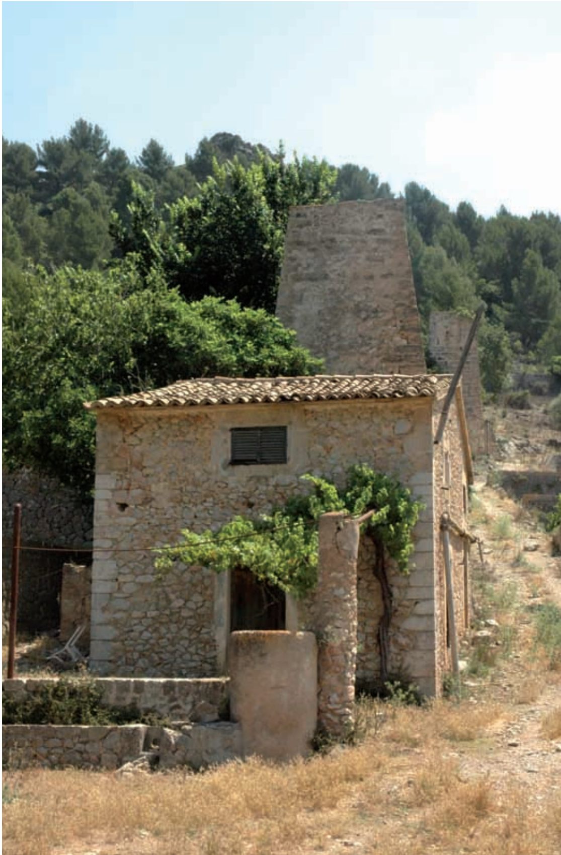
Figura 192. Molí Jussà, con caseta de molinero adosada, del sistema hidráulico de Galatzó.
