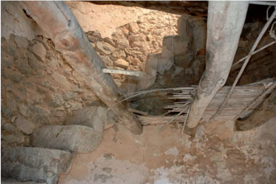
Figura 173. Tramo de escaleras del Molí des Castellet, formado por sillares rectangulares de piedra introducidos en el muro de la torre.
