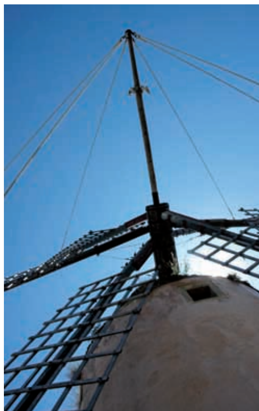
Figura 182. Antenada y eje del Molí de Santa Ponça.
