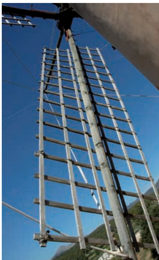
Figura 181. Aspas del Molí de Santa Ponça, donde se aprecia la disposición de la antena y las "perllonges".
