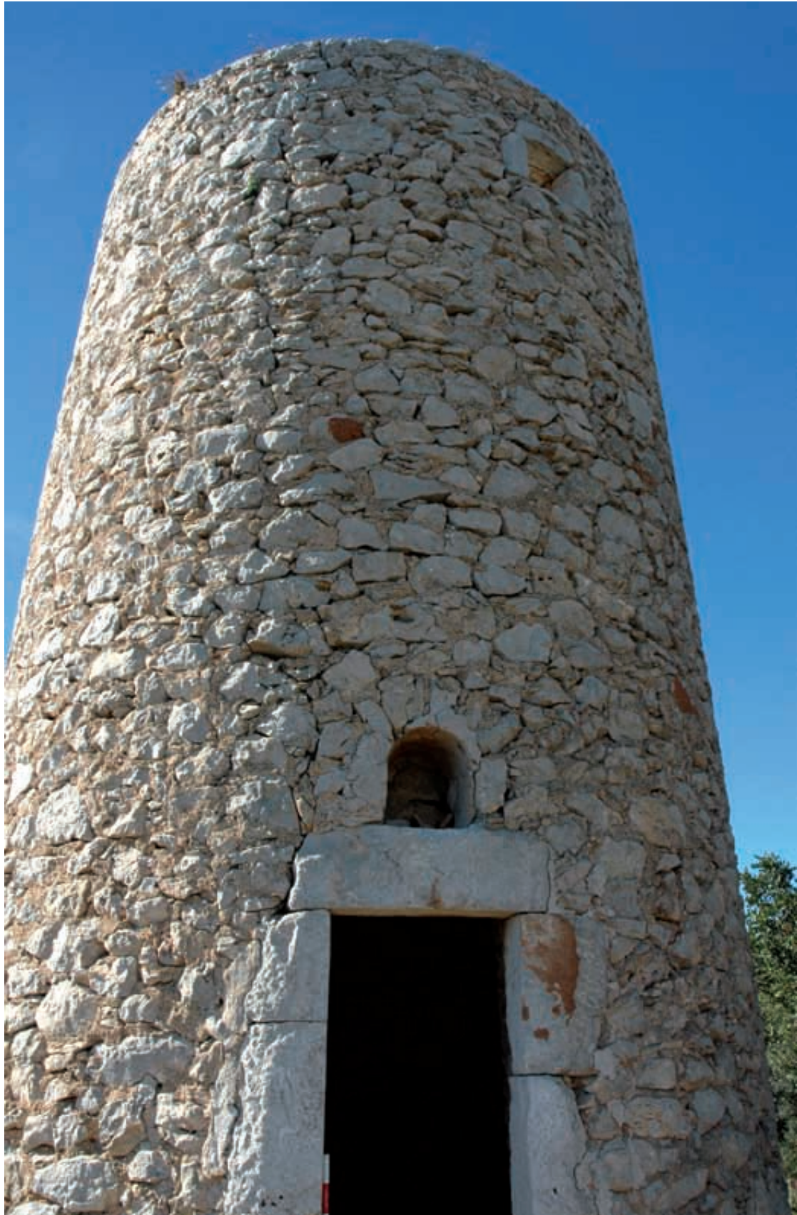
Figura 172. Torre del Moli des Castellet, donde se puede apreciar la fornícula descansando sobre el dintel de la puerta de acceso.
