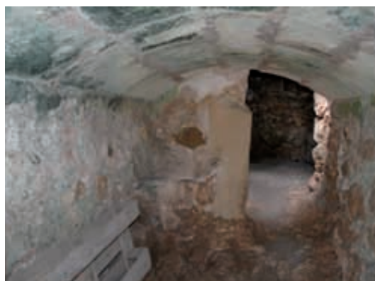
Figura 176. Molí d'en Banya, estancia interior con cubierta abovedada de sillares de arenisca.
