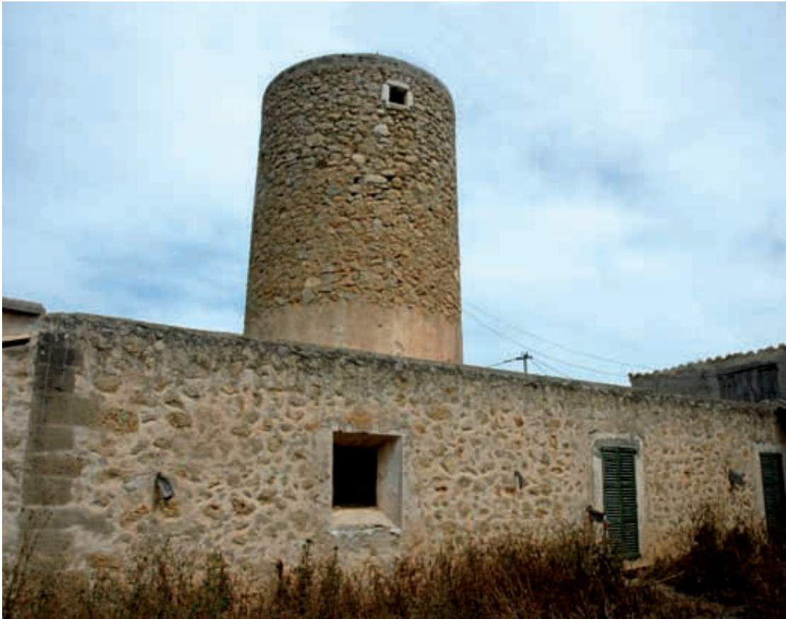
Figura 180. Conjunto compuesto por la Torre del Molí Nou de Calvià y la casa.
