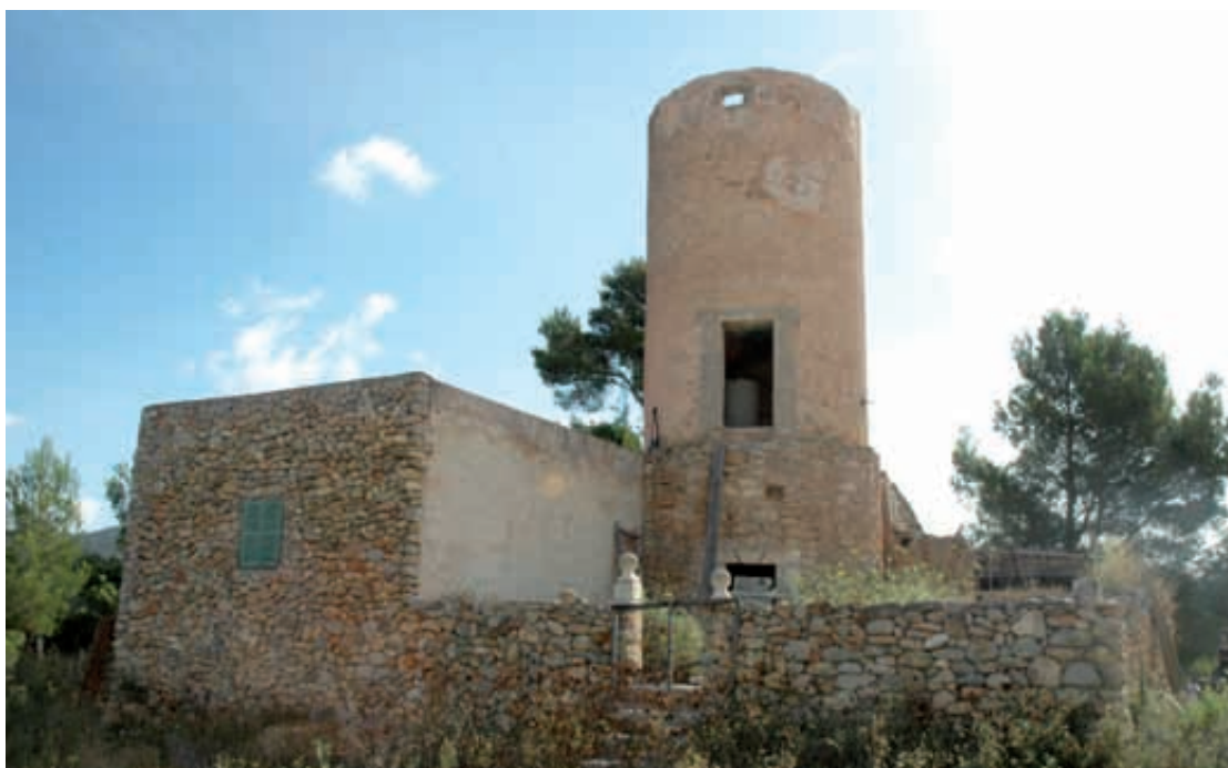
Figura 177. Molí Nou de Son Martí donde se aprecian la estancia adosada, las dos puertas, y el tratamiento diferenciado del muro.
