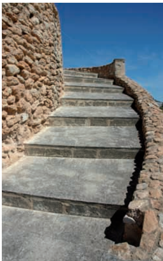
Figura 178. Escaleras de acceso al "envelador" adosadas al "cintell". Molí de Santa Ponça.
