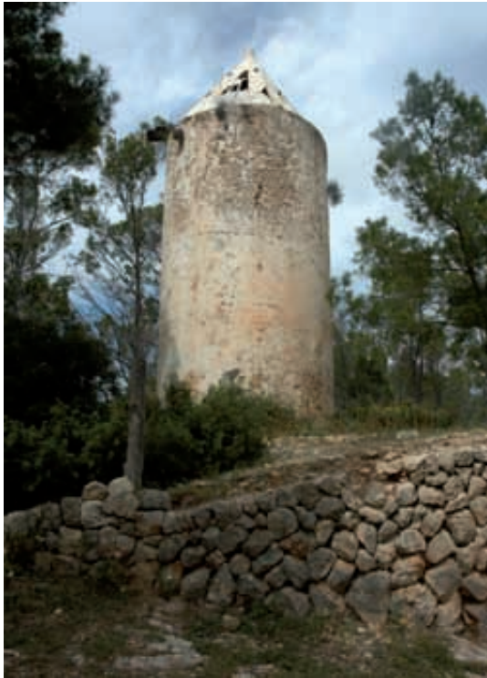
Figura 174. Molí d'en Banyà, que conserva restos del "capell".
