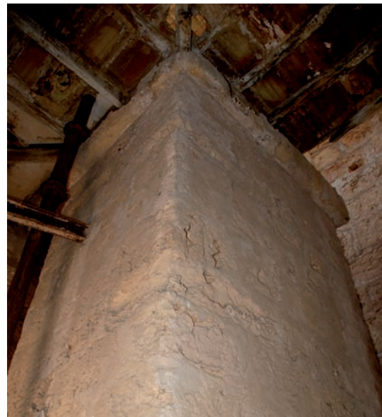
Figura 152. Antigua torre maciza embutida dentro del molino de Son Alemany.
