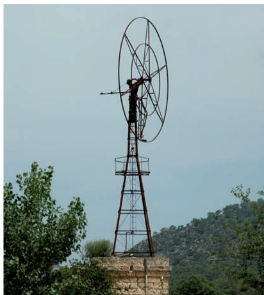
Figura 153. Molino del vivero de Sa Porrassa con la caja, la rueda y el eje vertical.
