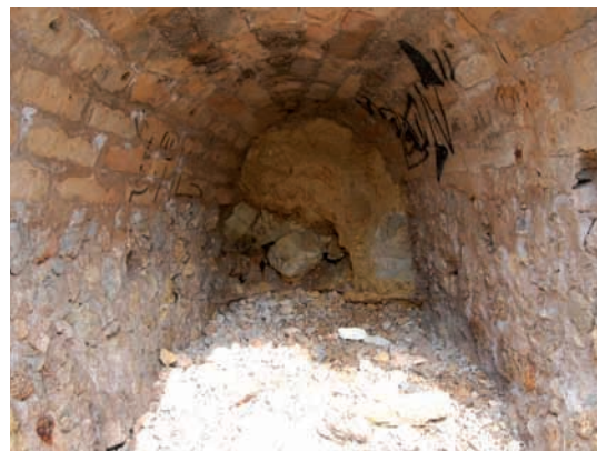
Figura 249. Interior del varadero 1 de Sa Punta des Terrers.
