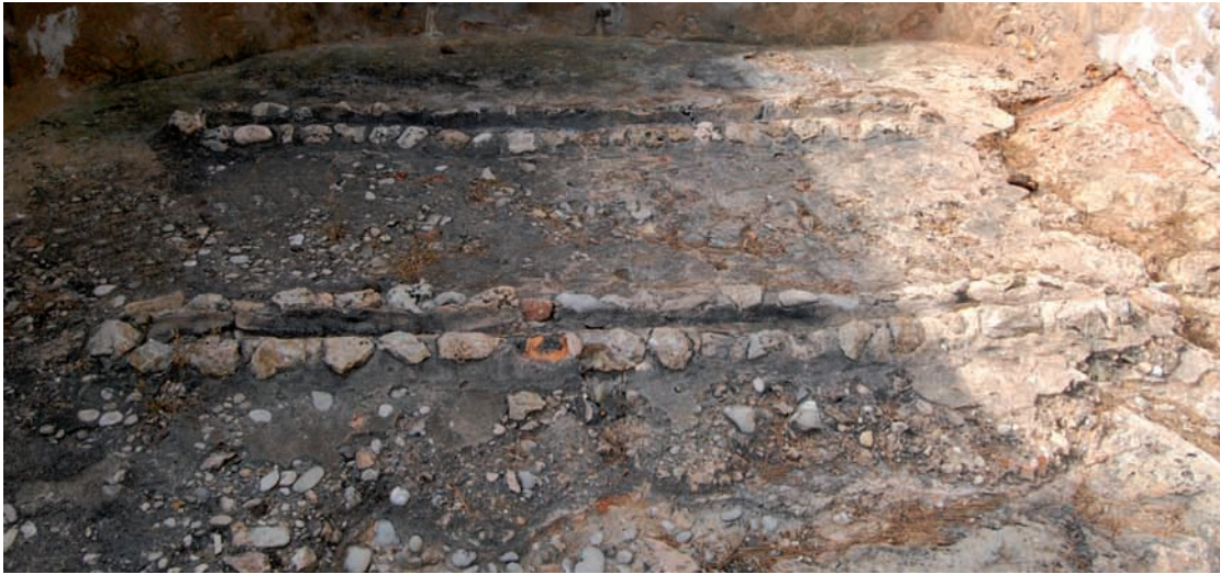
Figura 247. Detalle de la rampa interior del varadero 2 de Sa Punta des Terrers.
