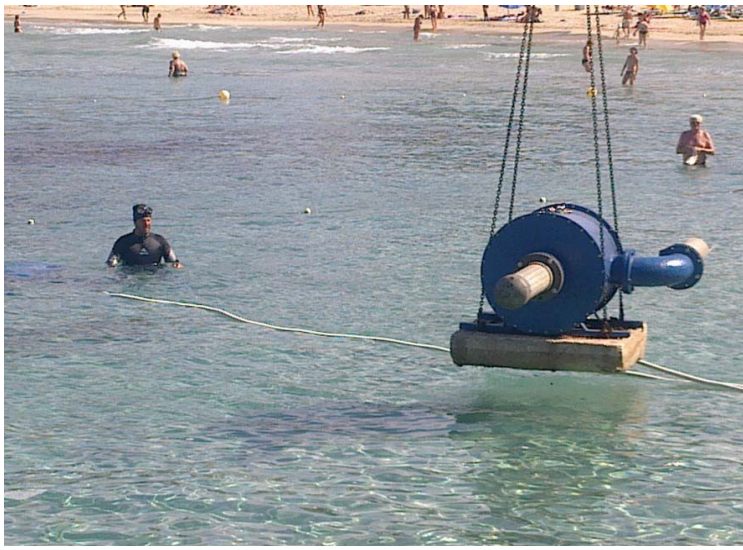
Instalación de bombas
