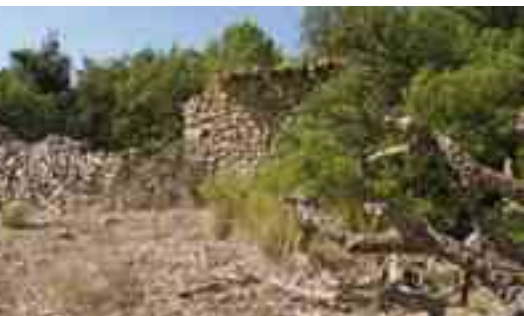
CASETA DE ROTER A SA VINYA
