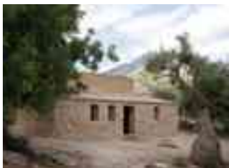
CASETA DES TRAMUNTANAL
