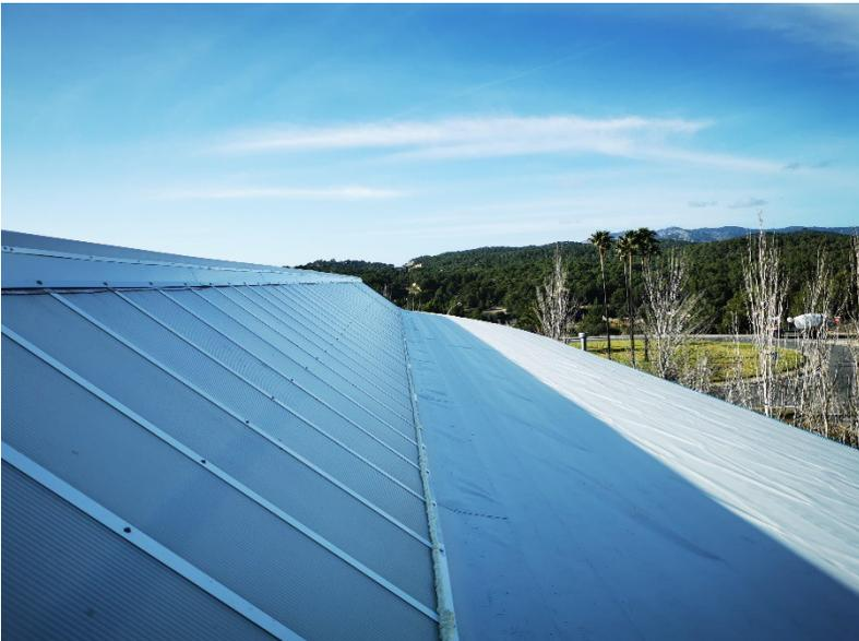
Ejecutada la primera fase, siguen notificándose filtraciones de agua en algunos puntos de la instalación deportiva, presumiblemente causadas por defectos existentes en los faldones no intervenidos en la primera fase, haciéndose necesario completar la rehabilitación del resto de cubierta.
