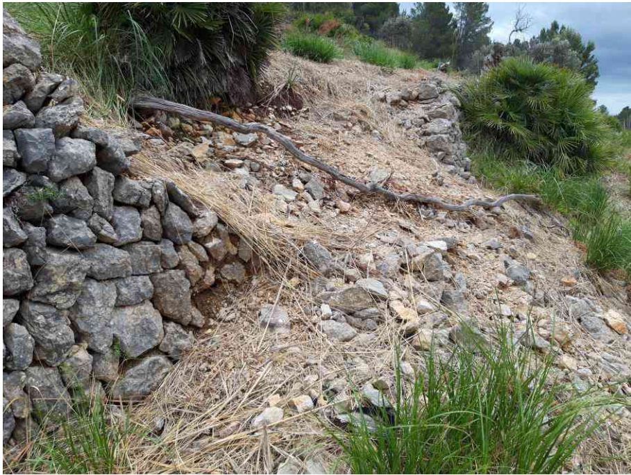
Detall de l'estat dels trams per reconstruir a na LLaneres
