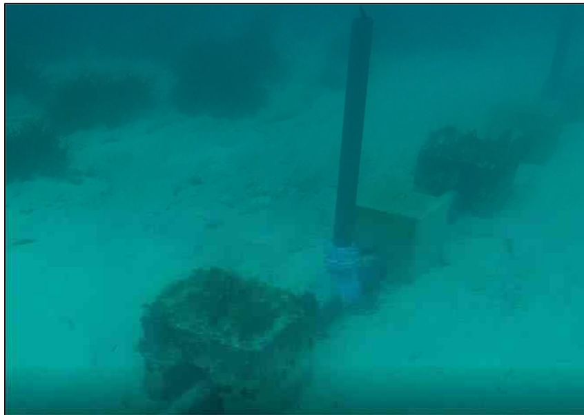
Detalle boquillas difusores colocadas verticalmente al ramal
